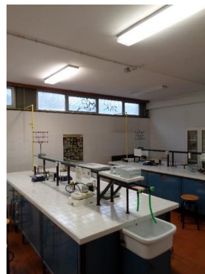
Figura 4.19 - Particolare dei corpi illuminanti ubicati nei laboratori
