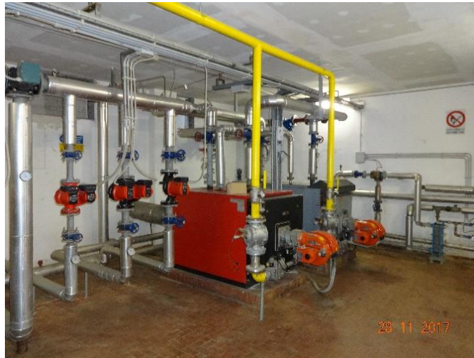
Figura 4.12 - Caldaia a basamento
