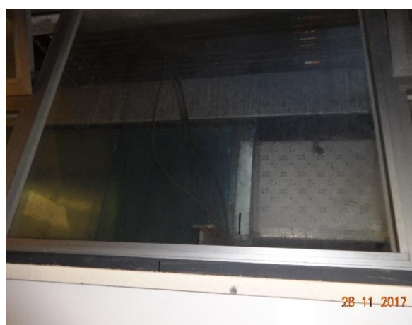
Figura 4.4 - Particolare dei serramenti
