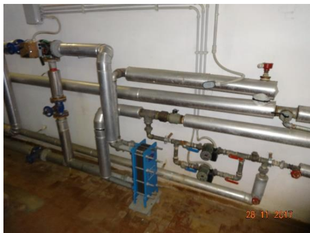
Figura 4.15 - Scambiatore di calore a piastre
