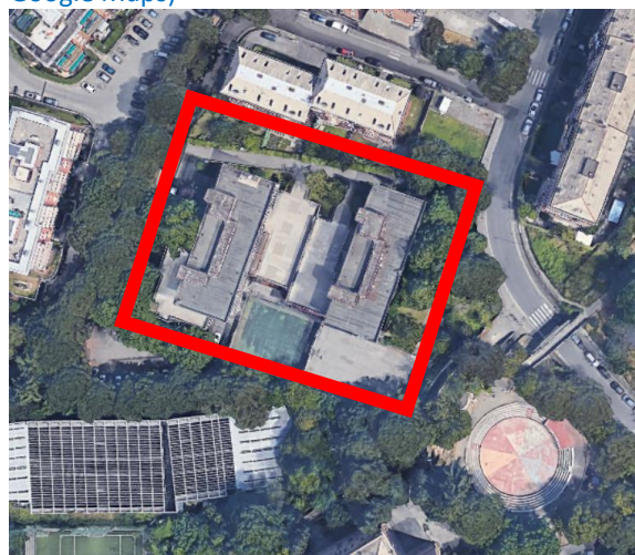
Figura 2.2 - Vista satellitare dell'edificio (Fonte: Google Maps)
