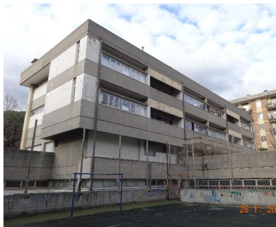
Figura 1.1 - Vista della facciata Sud-Est
