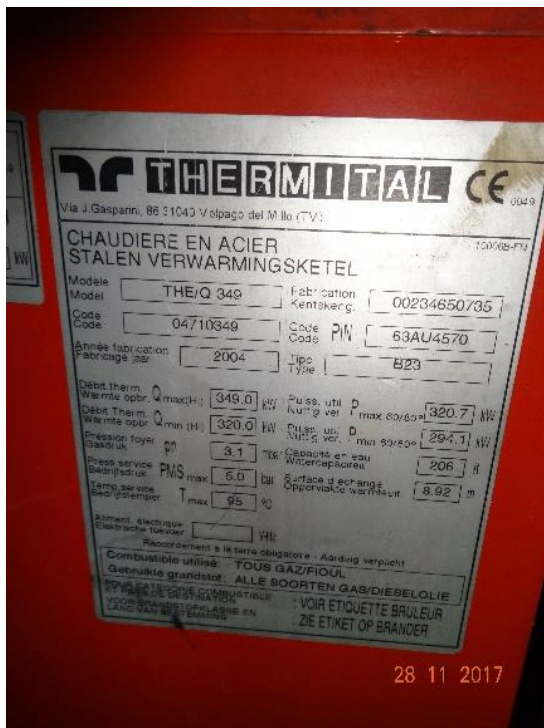
Figura 4.13 - Targhetta caldaia 1
