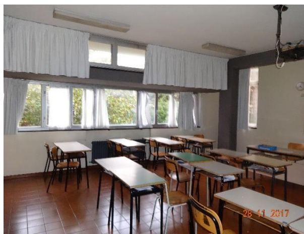
Figura 8.1 – Particolare dei serramenti esistenti
